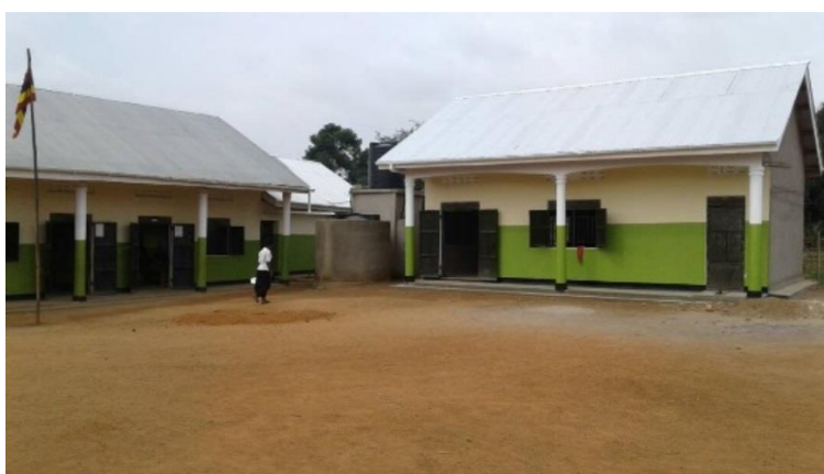
2017 nieuw klaslokaal, daarin verborgen de pompinstallatie
